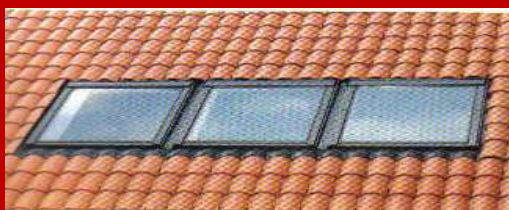
Montaža strešnega okna
